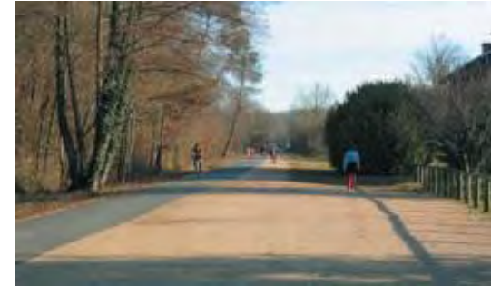
Source : Voie Verte entre Bordeaux et Sauveterre de Guyenne (Gironde) Les piétons, cyclistes et "joggers" se déplacent indifféremment sur l'enrobé et le sable stabilisé, CETE Sud/Ouest, O. Gouet
