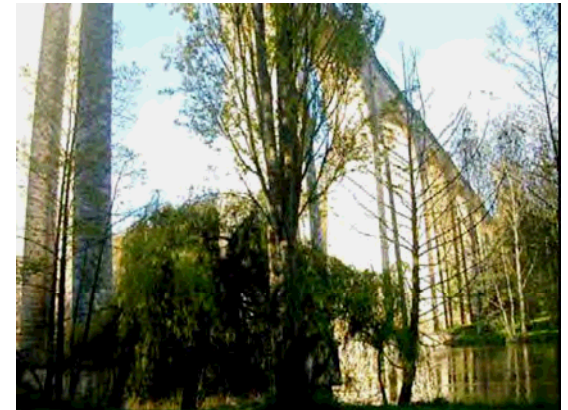
Source : Viaduc de Le Blanc et l'ancienne voie-fermée Argenton-Tournon : une opportunité pour structurer une offre cyclable dans le territoire de la Brenne, ALTERMODAL (Schéma Régional de VVV en Région Centre)
