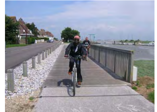
Source : Passerelle en Baie de Somme, Syndicat Mixte Baie de Somme du Grand Littoral Picard
