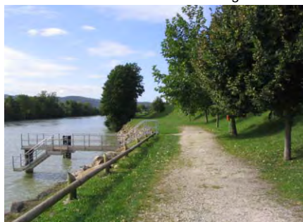
Chemin de halage en bon état
