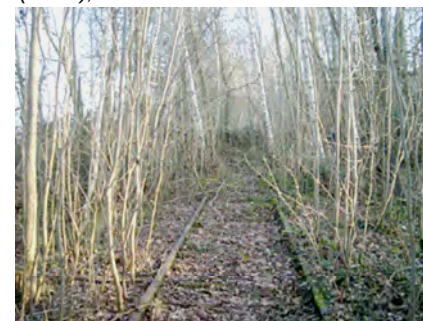
Source : Végétation envahissant l'emprise ferroviaire entre Betz et Antilly (Oise), Sécheresse Consultants
